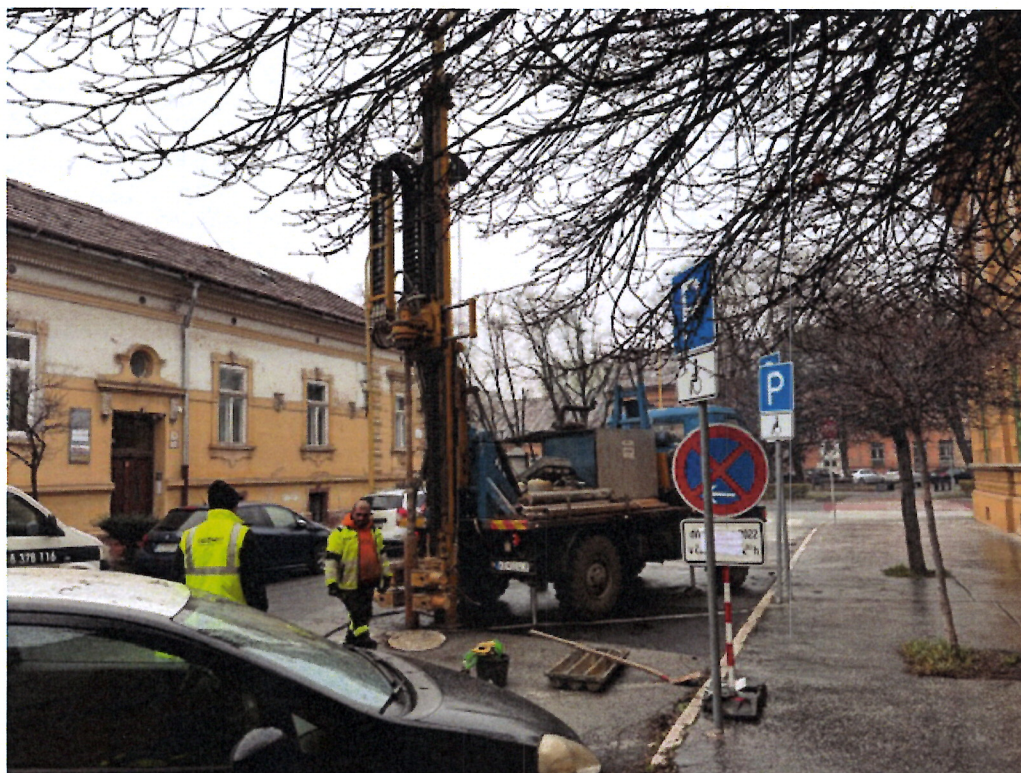
V4 (ul. Zbrojničná) 0,00 – 0,08 m asfalt 0,08 – 1,00 m hnedý íl tuhý – mäkký štrkovitý
